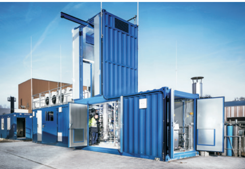
Abb. 3: Pilotanlage zur Erzeugung von erneuerbarem Methan mittels Drei-Phasen-Methanisierung
